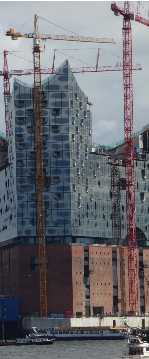
Bei der Elbphilharmonie übernahmen Hanack und Partner die geodätische Bauüberwachung.
