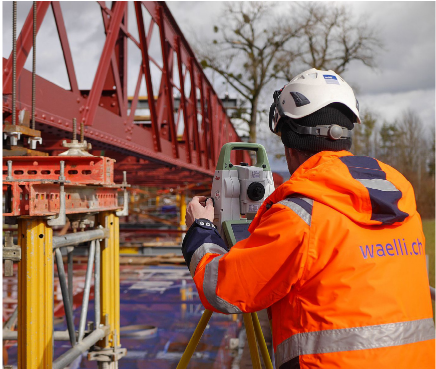
rmDATA-Produkte liefern Grundlagendaten und Auswertungen von Absteckungen und Achsangaben für Baustellen, wie hier am Beispiel einer Brückenhebung über die Thur.
