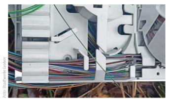
Voller Überblick in Glasfaser-Spleißboxen und bei Faserwegen: Die aktuelle Version von Smart Networx hat dafür einiges zu bieten.
